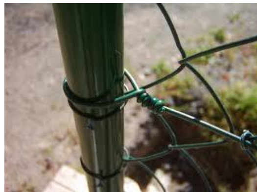
Detail ukončení napínacího drátu kolem sloupku
