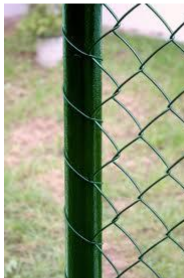
Přichycení pletiva vázacím drátem ke sloupku
