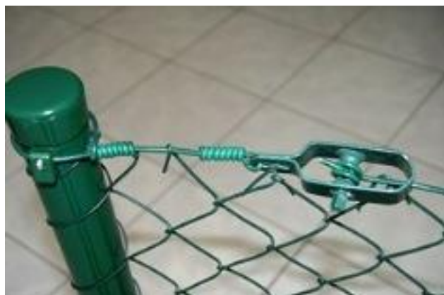
Detail napínací kladky k vypnutí drátu
