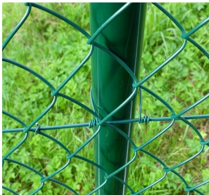
Prostřední napínací drát přichycený pomocí vázacího drátu k plotovému sloupku
