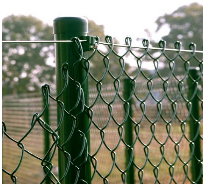
Háčkování zahradního pletiva k napínacímu drátu společně s detailem zatloukací příchytky
